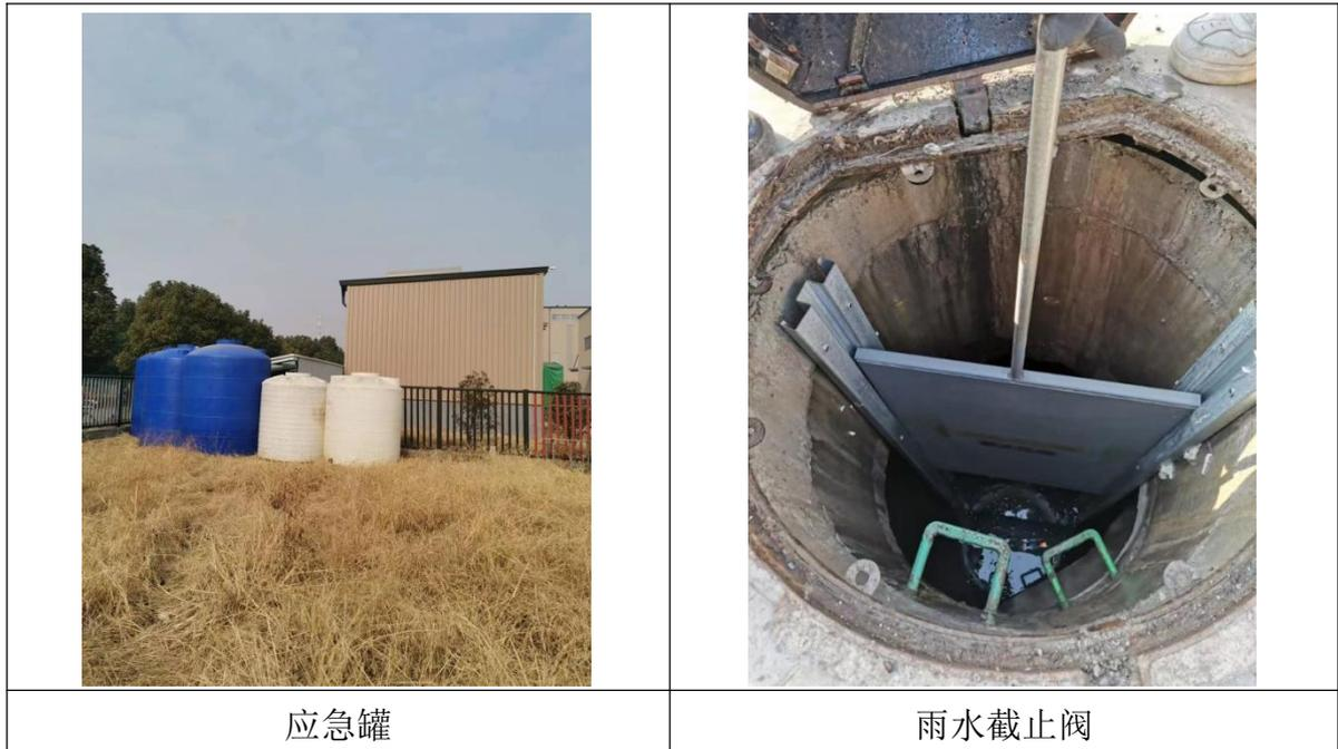
图 4-4 企业应急罐及雨水截止阀照片
