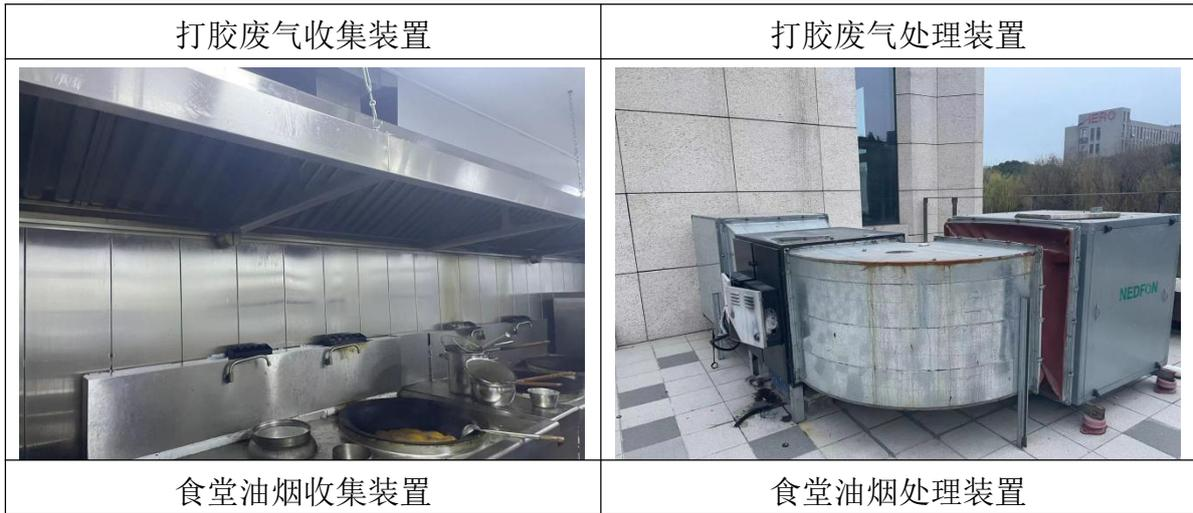
图 4-2 企业废气处理设施照片
