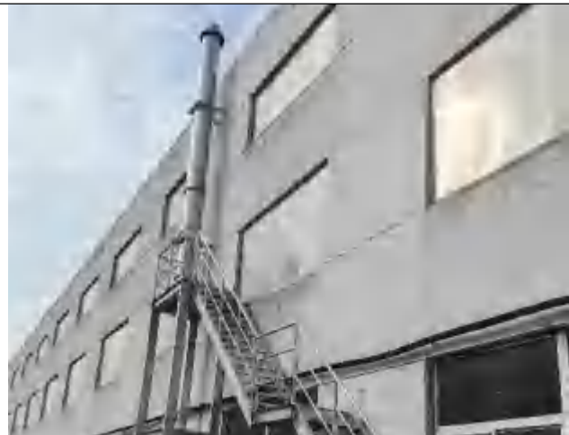
老厂区喷砂废气 DA062 排放口及对应废气处理设施、生产设备
