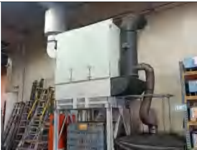
老厂区机加工废气 DA009 排放口及对应废气处理设施、生产设备
